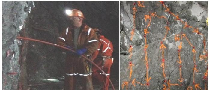
que les trous de mine du périmètre n'étaient pas visibles, il y avait des déblais provenant d'une faille géologique à 1 m le long du mur du périmètre.
