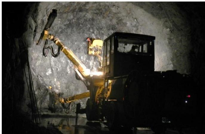
pour environ 2000 m du tunnel de dérivation de l'eau de 9,6 m de largeur x 9,8 m de hauteur.
